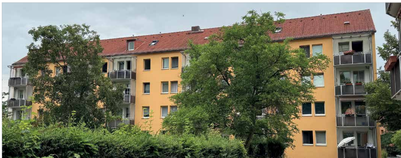
Fassade Straße des Aufbaus 1–5
