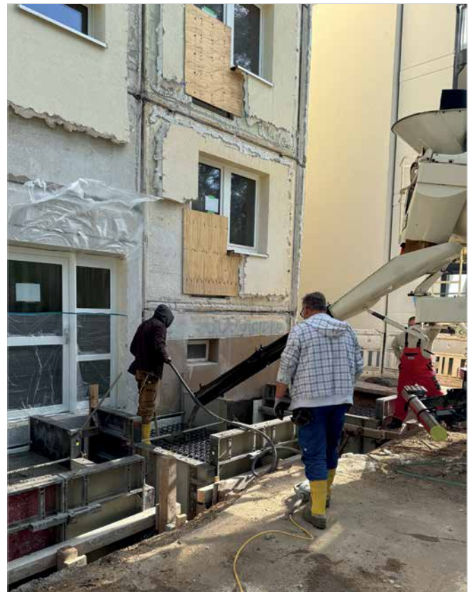
Herstellen der Fundamente für die neuen Balkone
