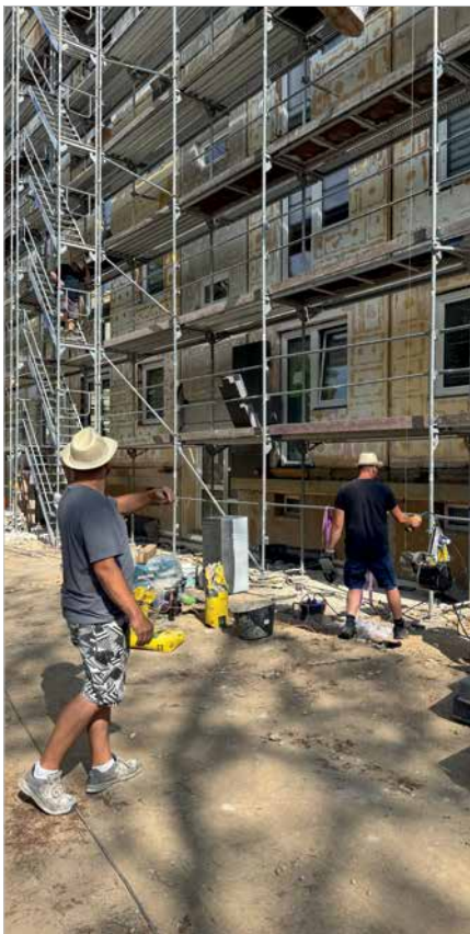
Es wird fleißig an der Fassade gearbeitet
