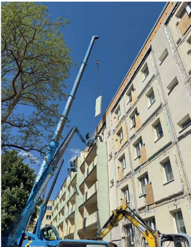
Demontage der alten Balkonanlage
