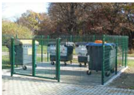
Südstraße 15, erneuerter Müllsammelplatz
