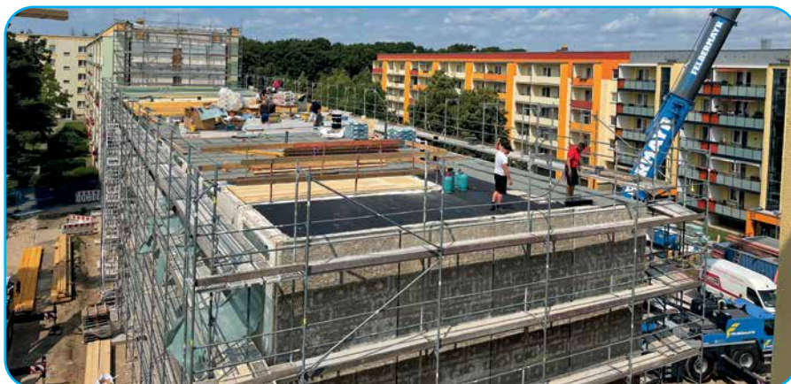
... nach Abschluss Teilrückbau
